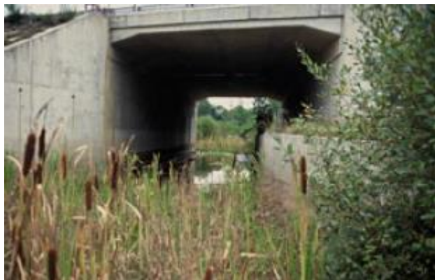
Figuur 2.8: Voorbeeld faunapassage Geleenbeek N276 en nieuwe infrastructuur (MJPO, 2013).
