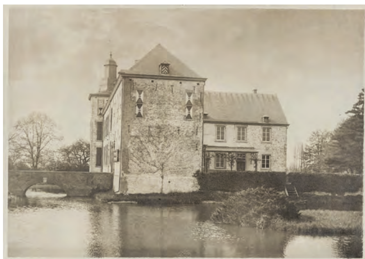
Foto van de westgevel van de zuidvleugel, met kunstig gesnoeide en geleide heester tegen de muur, ongedateerd. Rechts een deel van het eiland in de vijver. (Bron: RCE, nr. OF06026).
