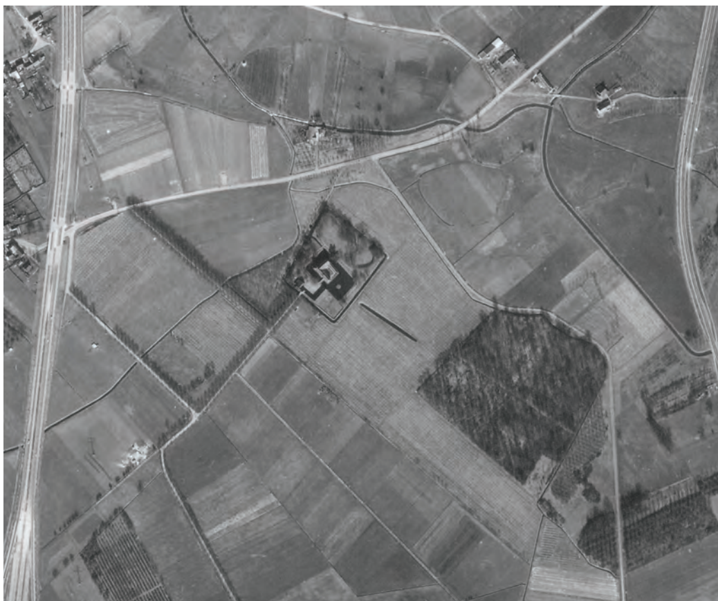
Luchtfoto, 1965. (Bron: Kadas- ter).
